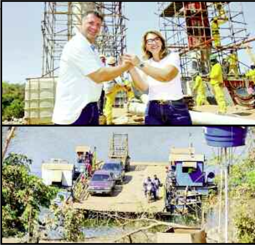
Prefeito Elieudes e secretária fazem vistoria em canteiro de obras
