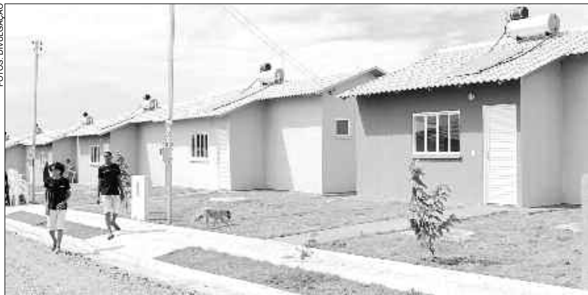
Casas entregues em Rianópolis: gestão que foca em realizar sonhos dos moradores do município
