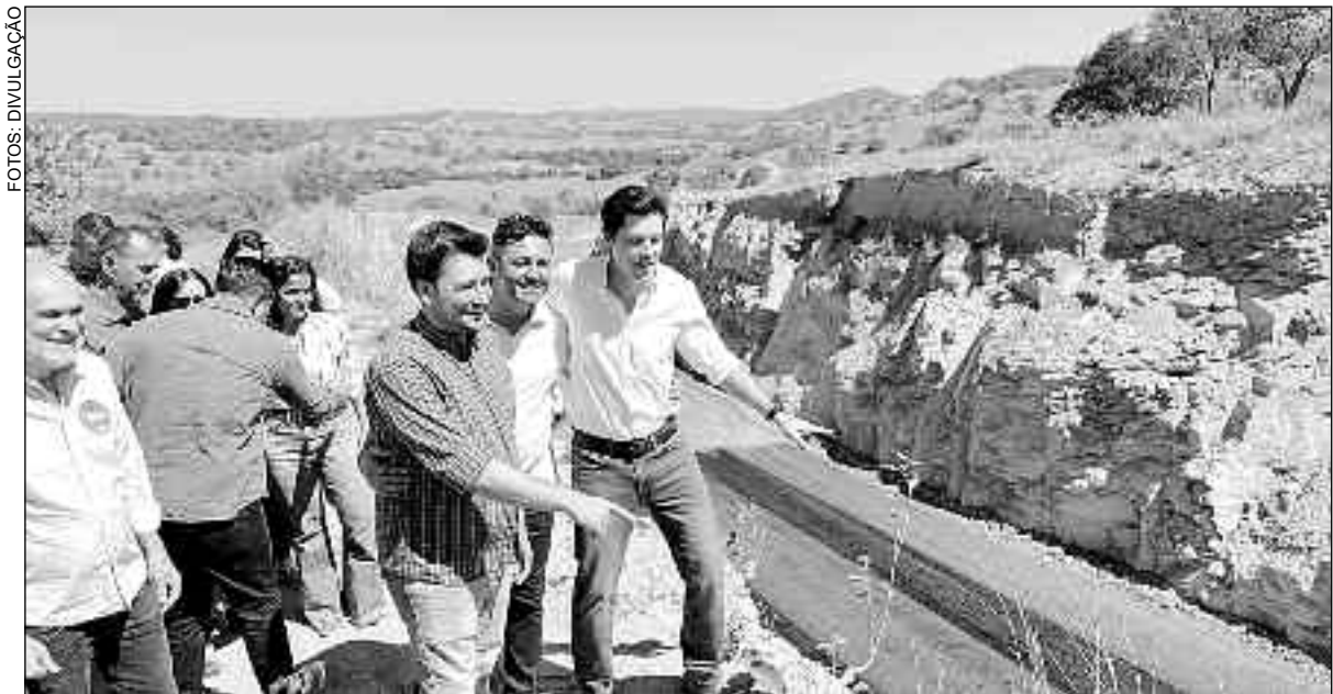
Obras de pavimentação de rodovia representam anseio e reivindicações antigas da população da região
