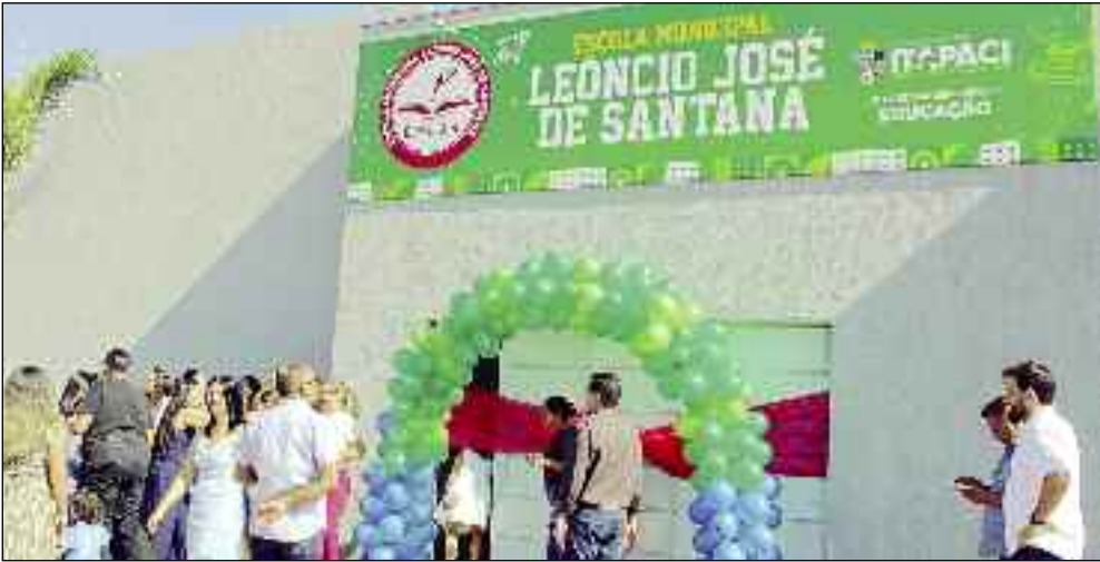
Fachada de Escola Municipal Leônicio José de Santana depois de reformada e ampliada
