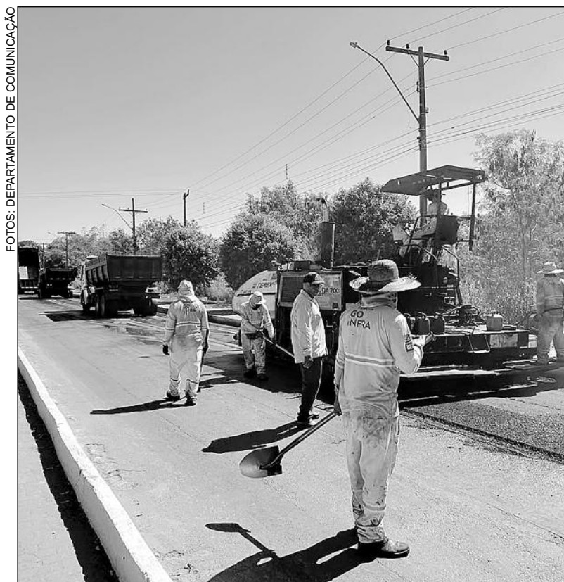
Obras de recuperação do pavimento asfáltico avançam em Itapaci
