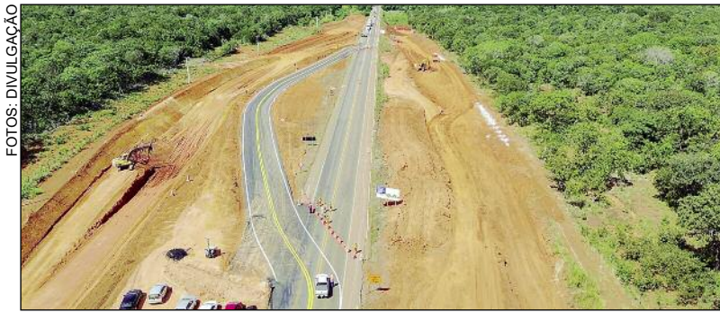
Imagem área mostra obras de duplicação da BR-153 no Norte
