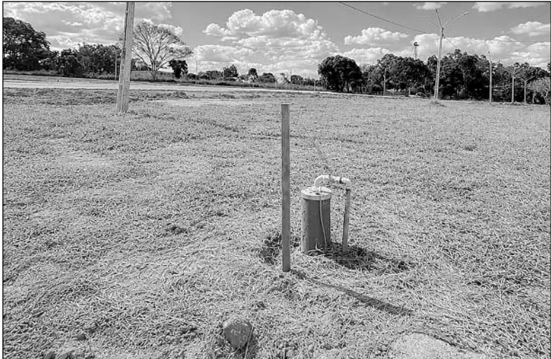
Poço artesiano vai garantir água ao parque, espaço de lazer e negócios
