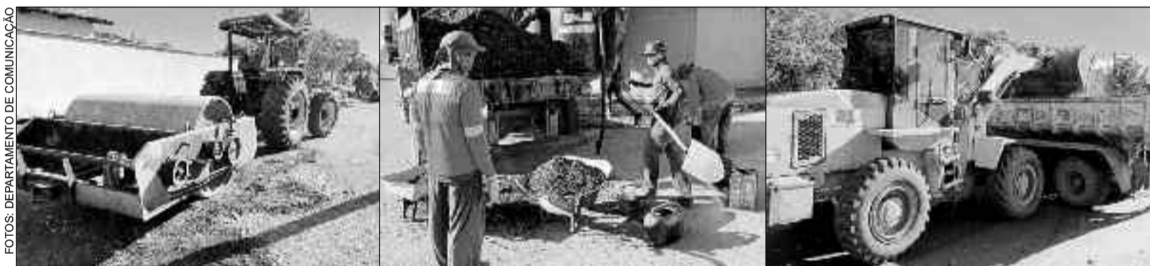
Secretário acompanha frentes de trabalho. Recuperando massa asfáltica. Operação tapa buracos e recolhendo entulhos
