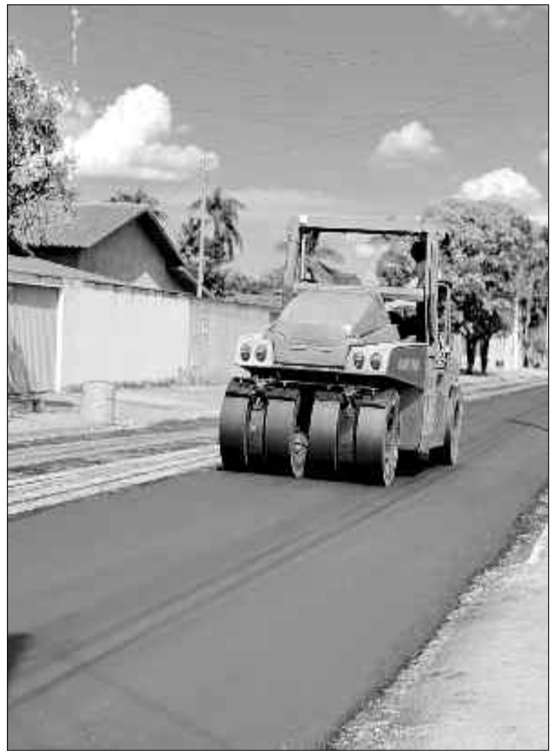
Trabalho executado para melhorar as condições de tráfego nas ruas
