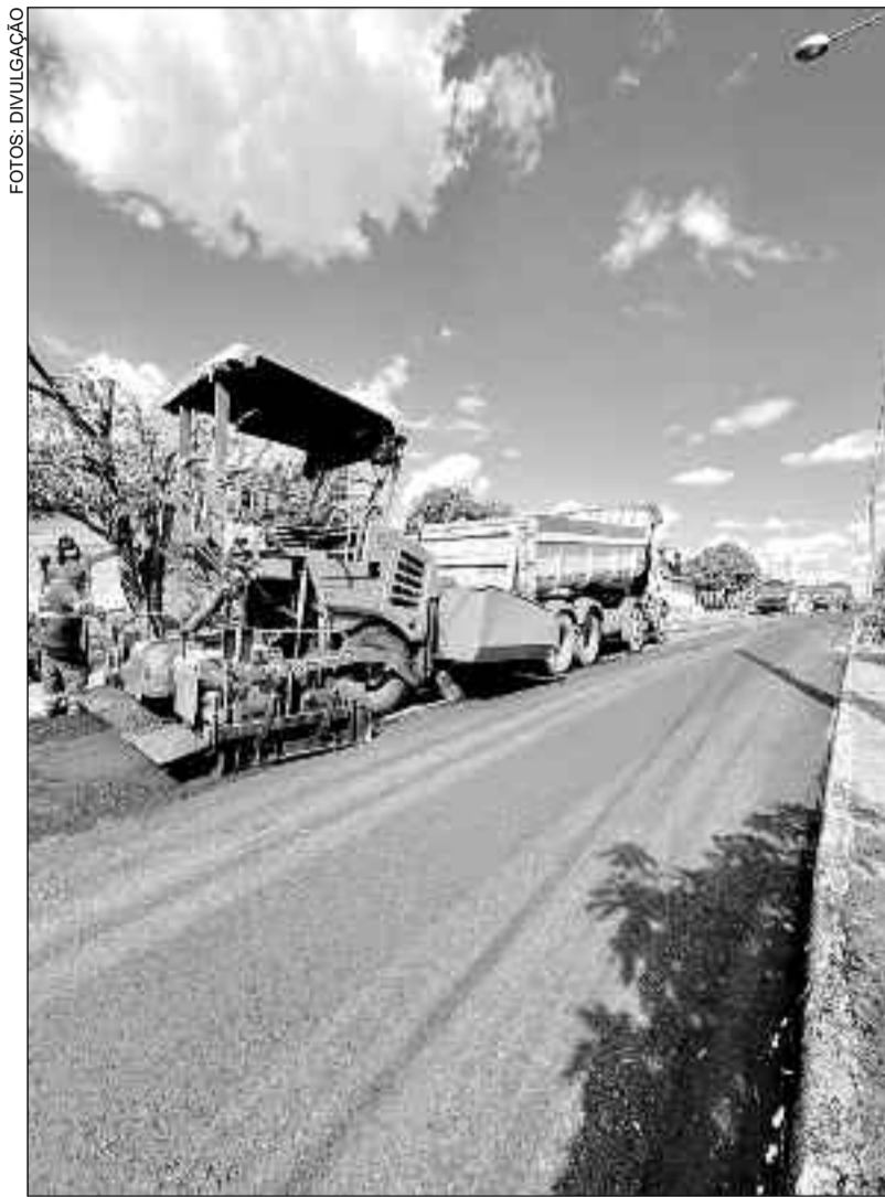
Várias ruas estão sendo beneficiadas com obras de recuperação
