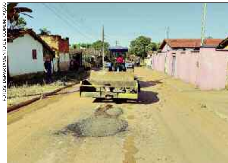
Operação tapa-buraco atende ao Distrito de Ponte Nova, em Itapaci
