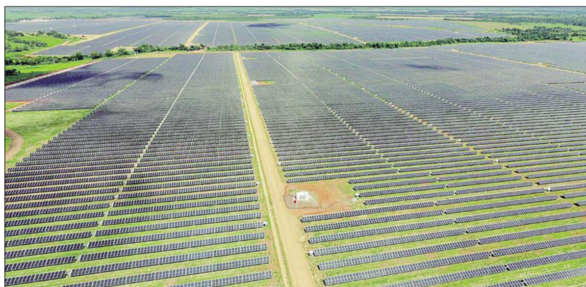
Usina de produção de energia solar localizada no município de Vila Propício, o maior de todo Centro-Oeste
