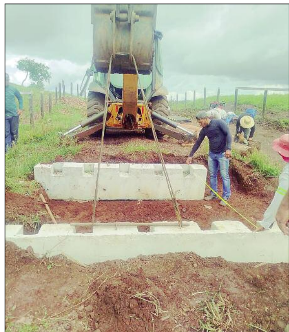
Fazendo a instalação de mata-burro no município
