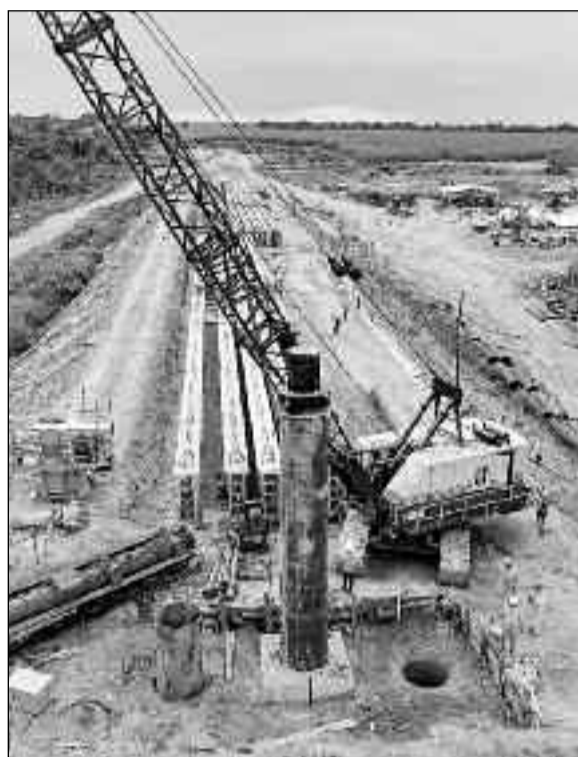
Perfuração de fundação para a estrutura da ponte
