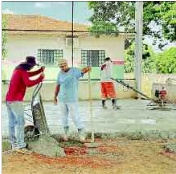
Colaboradores trabalham na instalação de piso
