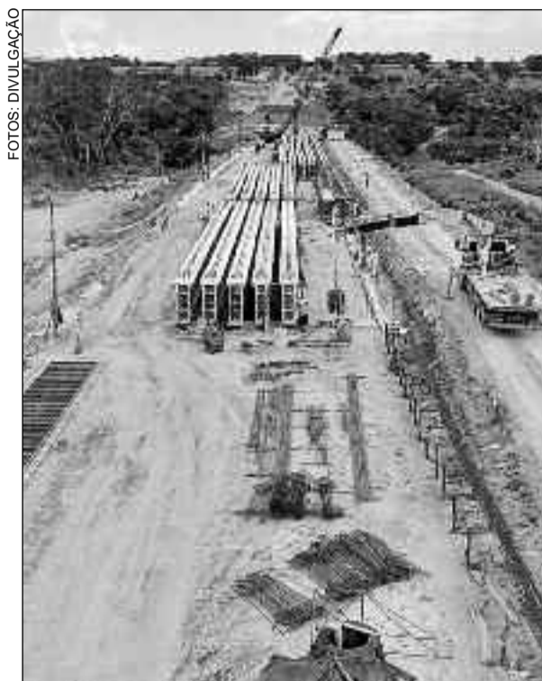
Imagem mostra canteiro de obras para fazer a ponte
