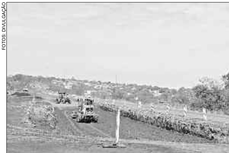
Obras de duplicação da BR-153 são iniciadas e vão atender Rialma
