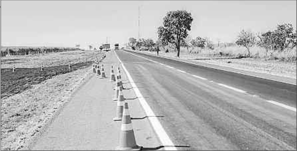
Obras no perímetro urbano da cidade é iniciado: marco para o desenvolvimento de todo o município
