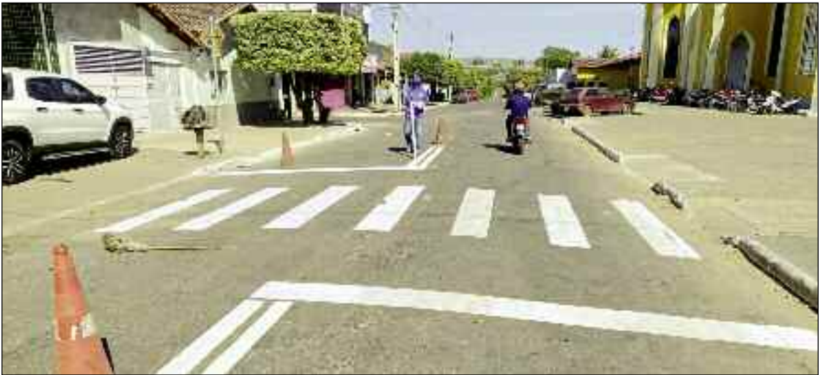
Colaboradores trabalham na instalação de nova sinalização para garantir mais segurança ao pedestres
