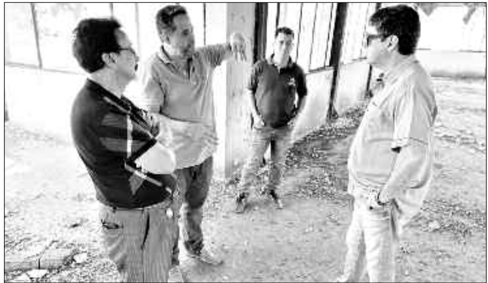
Prefeito vistoria prédio com engenheiros para definir o que pode ser feito no local
