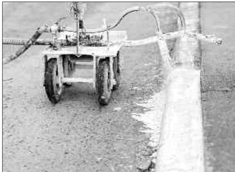
Equipamento faz a pintura dos meios-fios em todas as ruas da cidade
