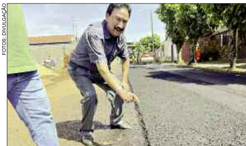
Prefeito Geraldo Reis fiscaliza obras de recapeamento em Carmo
