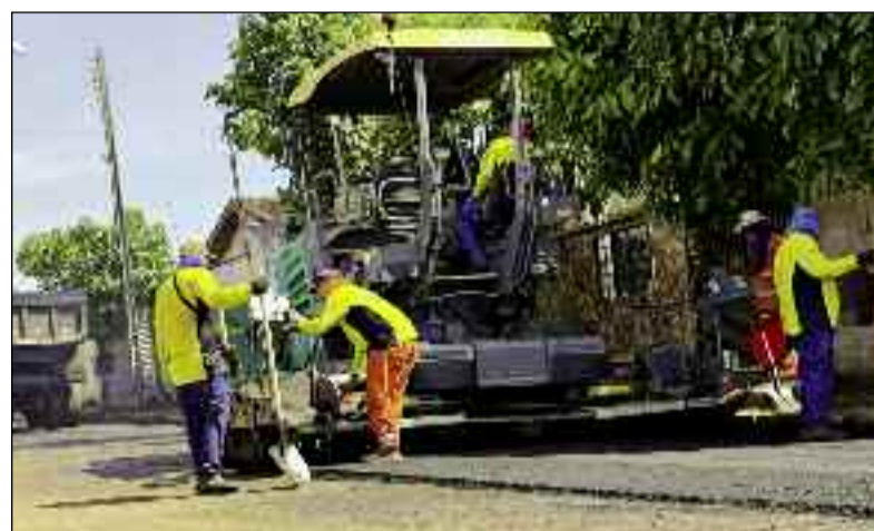
Trabalhadores realizam recapeamento de ruas na cidade de Carmo
