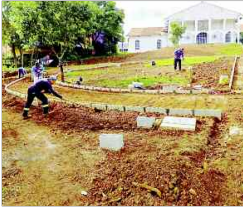
Local ficará mais confortável, bonito e aconchegante para moradores
