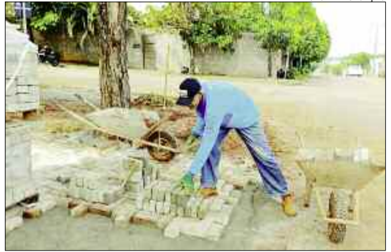
Operário trabalha na reforma da Praça das Oliveiras, em Rubiataba
