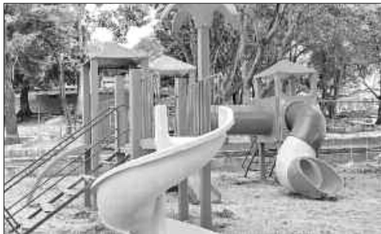
Briquedos já estão sendo instalados no principal parque da cidade
