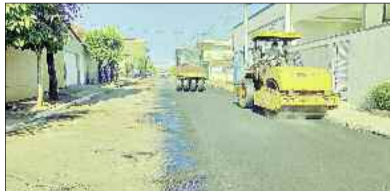
Ruas e avenidas agora recebem nova malha asfáltica: mais qualidade
