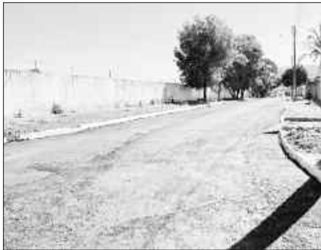
Obras de infraestrutura são executadas em toda a cidade
