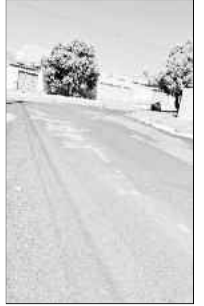
Bairro recebe massa asfáltica
