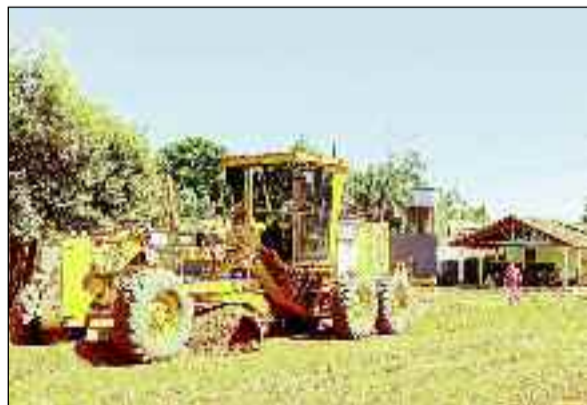
Máquinas para realização das obras no povoado
