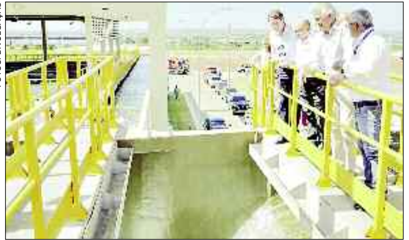
Sistema fortalece o fornecimento de água no entorno e em Brasília
