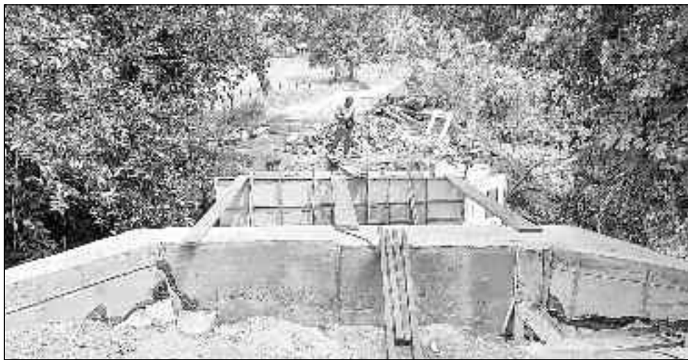
Obras de ponte pela zona rural de Uruana: infraestrutura que chega para o produtor
