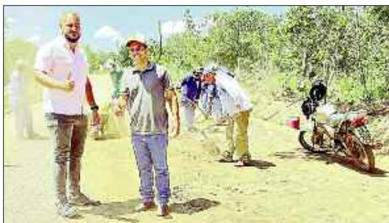
Prefeito acompanha a realização dos serviços no povoado da cidade
