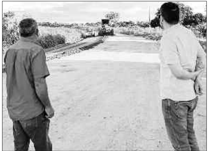
Obras avançam pela zona rural de todo o município de Jaraguá
