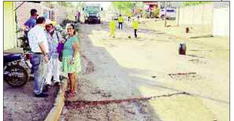
Recuperação da malha viária urbana: mais um compromisso resgatado
