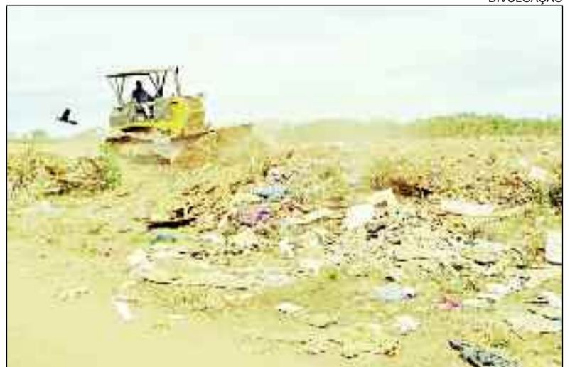
Máquina trabalha no lixão: para melhorar o meio ambiente local
