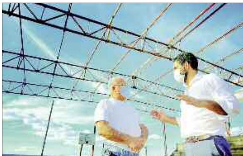
Obras da cobertura de quadra serão retomadas nas próximas semanas
