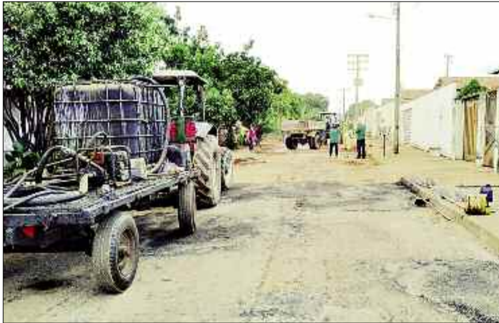
Trabalho de recuperação de vias são retomados para melhorar condições das vias e ruas
