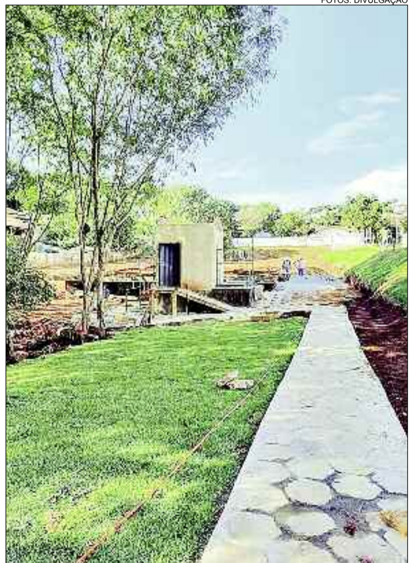
Novo parque começa a recuperar nascente: uma nova opção de lazer
