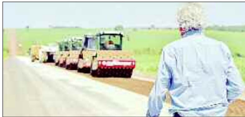
Governador Ronaldo Caiado visita canteiro de obras em rodovia goiana
