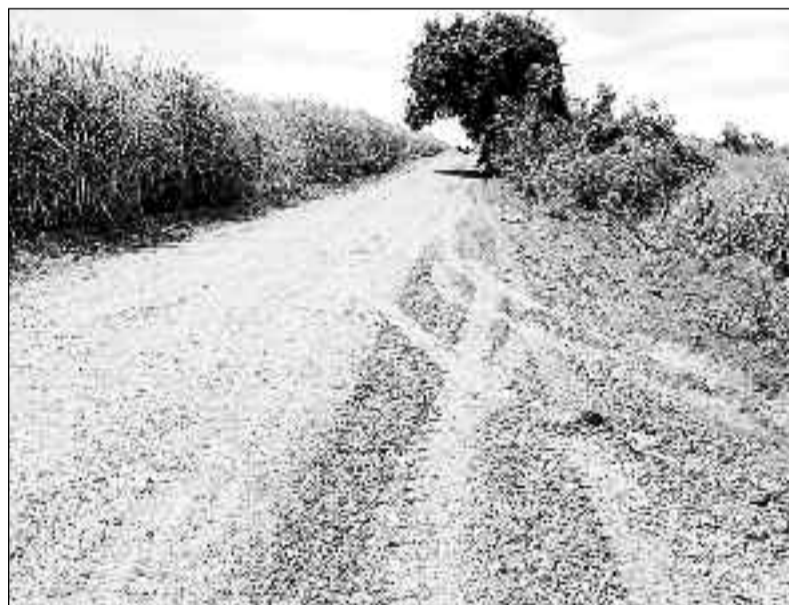
Trecho de estrada entre Itapaci e povoado de Fazendinha: recuperado
