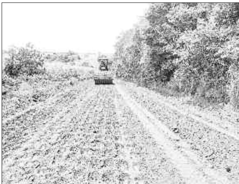
Trecho entre Itapaci e Crixás: também passa por obras de recuperação
