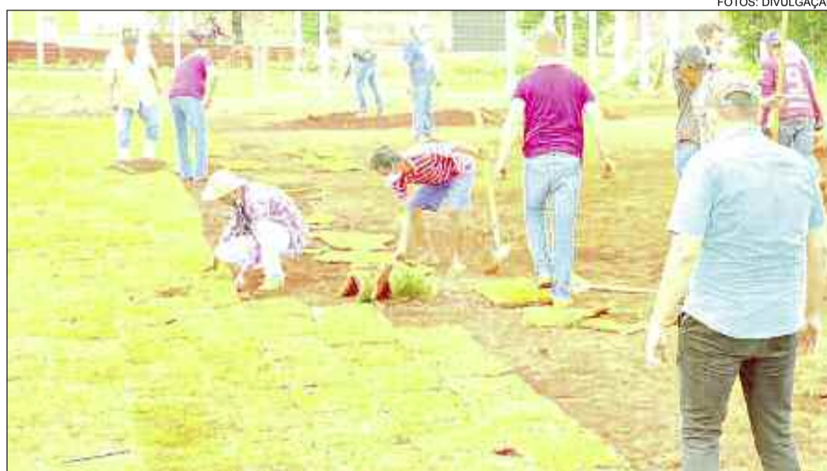
Prefeito Ney Canela vistoria obras de campo: mais lazer
