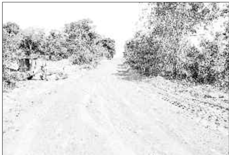
Trecho entre Itapaci e povoado Ponte Nova completamente recuperado
