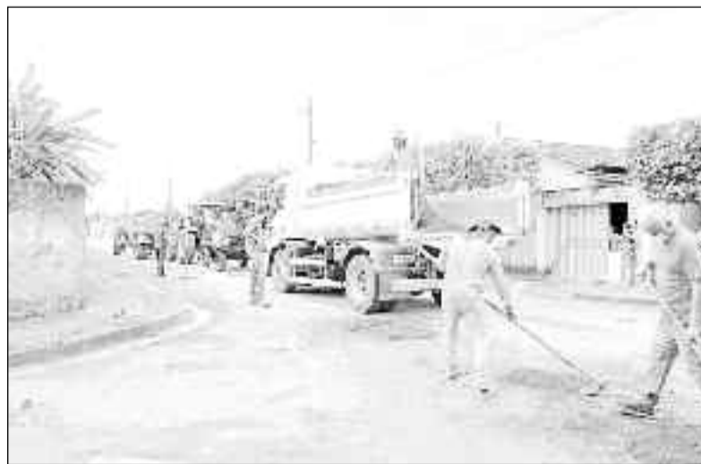
Trabalho para melhorar infraestrutura na cidade segue acelerado
