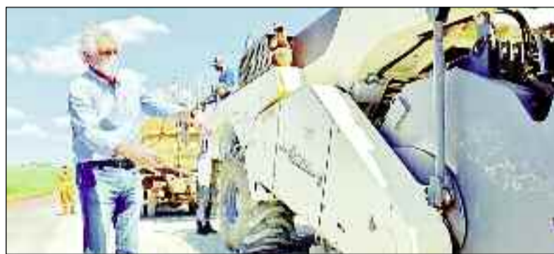
Governador Ronaldo Caiado visita obras de recuperação de GOs
