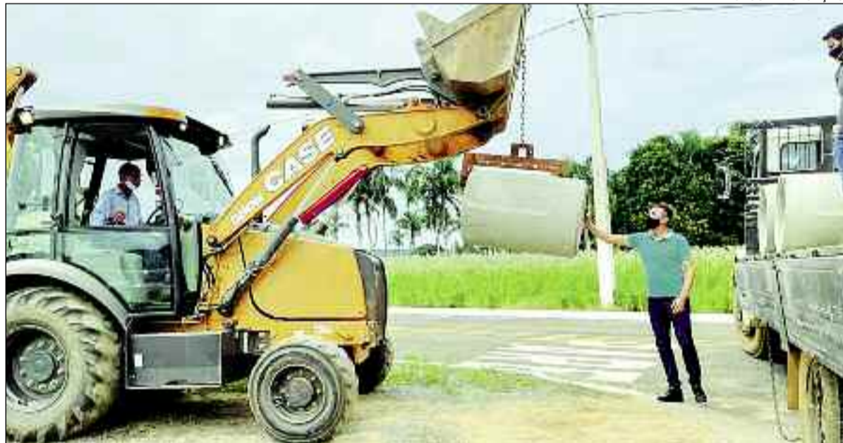
Prefeito Danilo Max acompanha a chegada de manilhas para a recuperação de estradas vicinais
