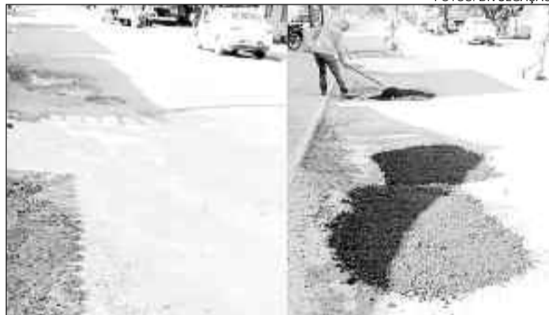
Ruas sendo devidamente recuperadas: compromisso de campanha
