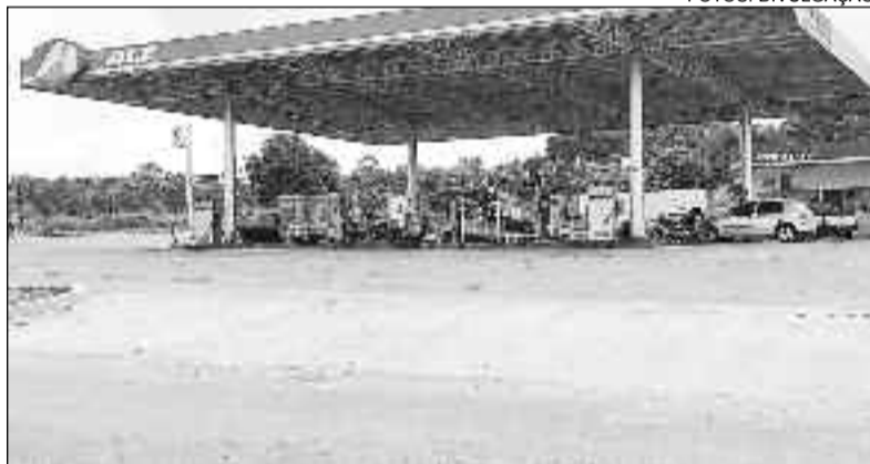
Obra concluída em frente a posto localizado no trevo de entrada
