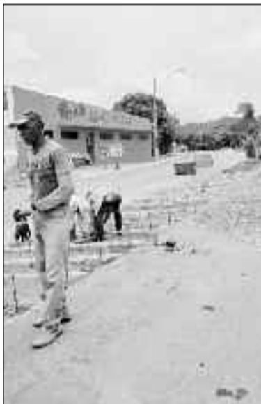
Servidores trabalham nas obras de reabertura de avenida
