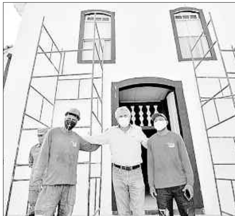
Governador vistoriou as obras de reforma de igreja de quase 200 anos
