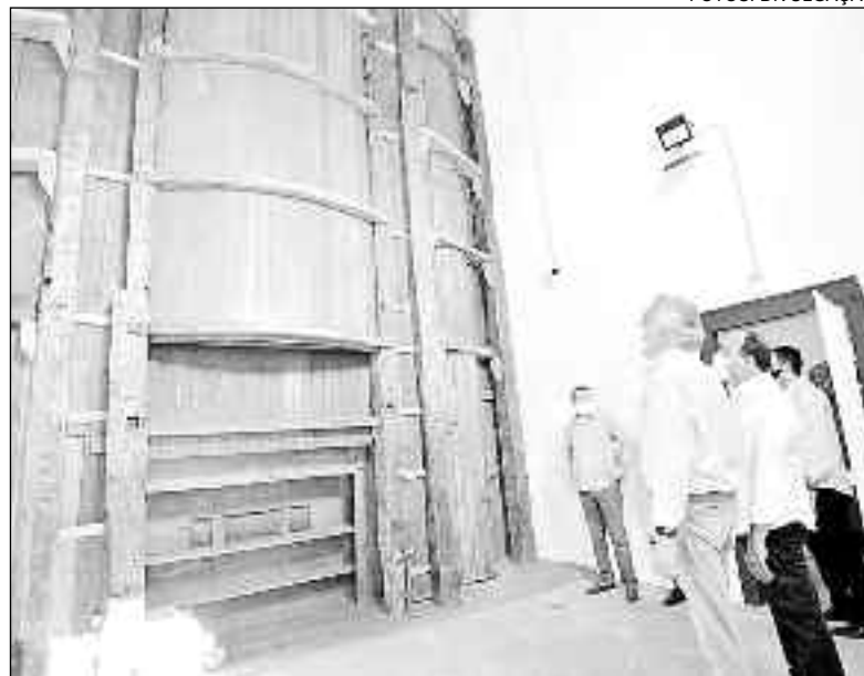
Igreja Nossa Senhora da Conceição está sendo completamente reformada
