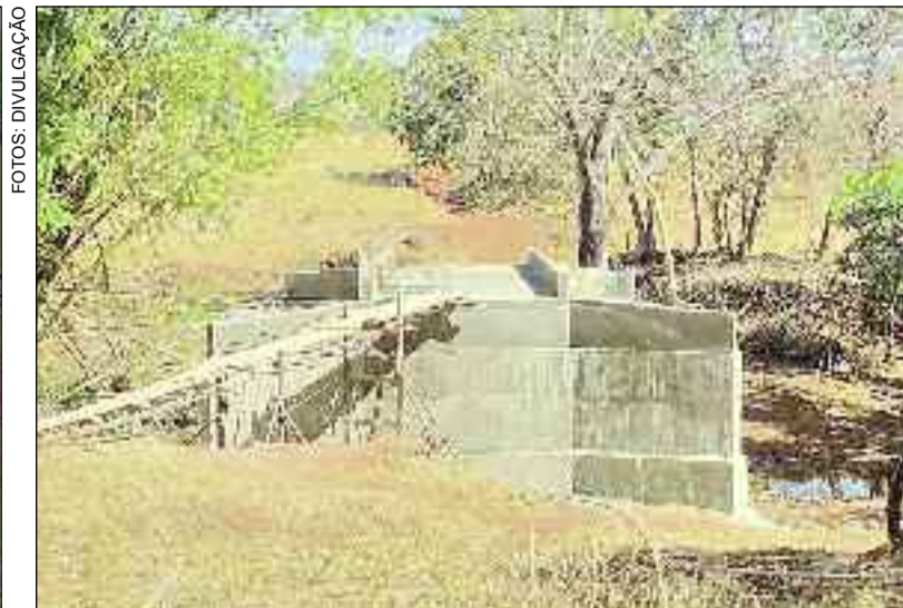
Mais cinco pontes estão em fase final de construção e serão entregues
