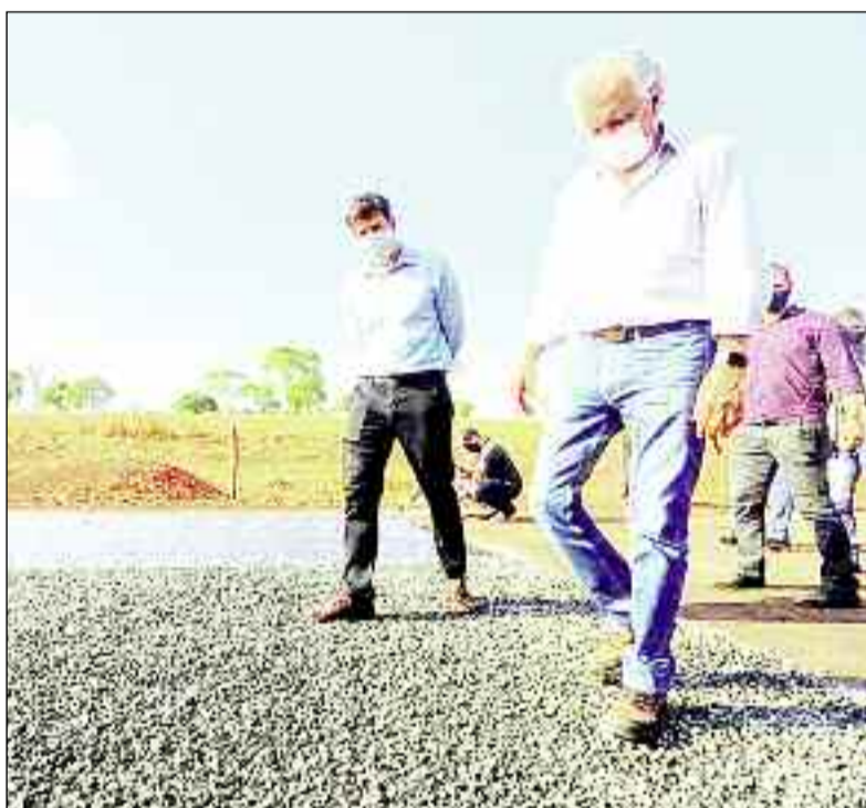
Governador Caiado e o presidente da GOInfra, Pedro Sales: nas obras
