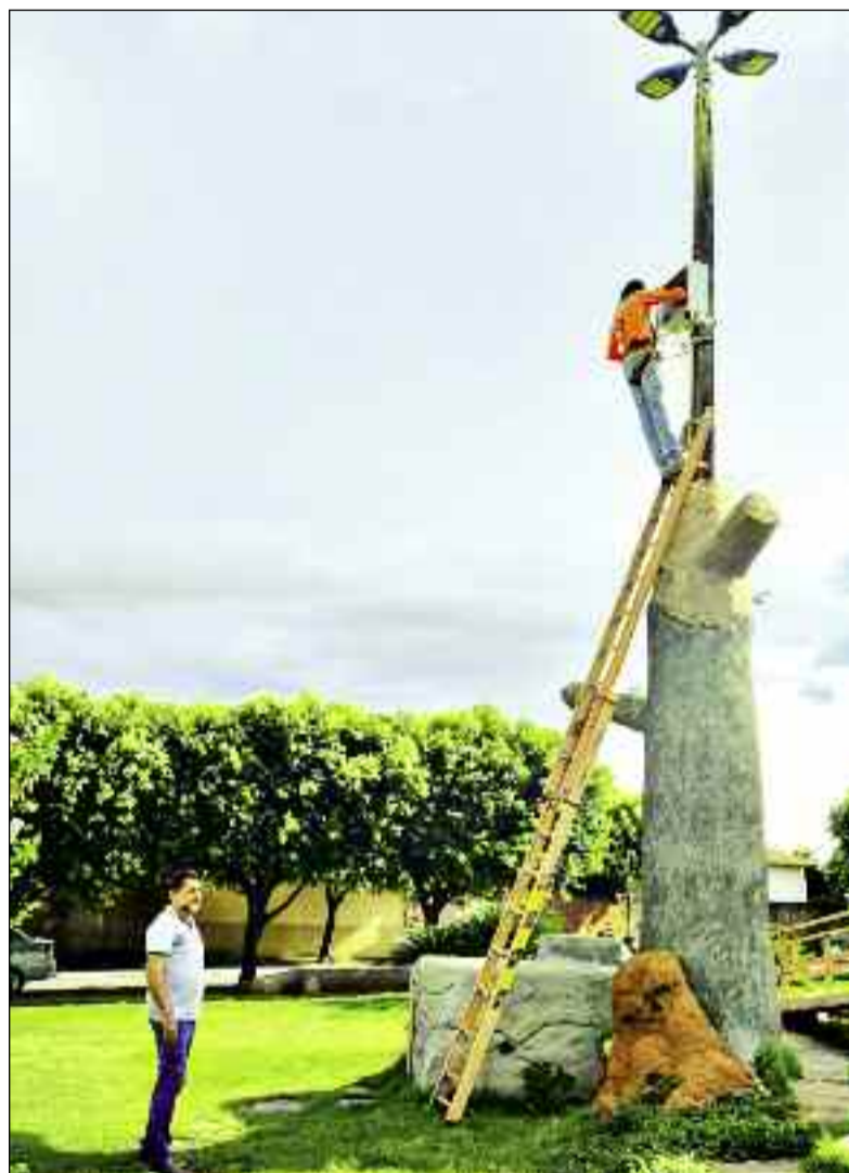
Câmeras sendo instaladas em pontos importantes de toda a cidade
