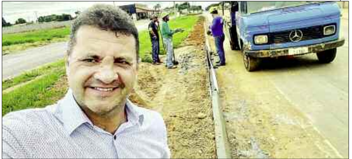
Prefeito vistoria execução de obras de construção de meio fio em toda a cidade de São Luiz do Norte
